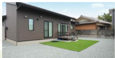
お庭には碎石+人工芝でお子様の遊び場も充実! プライバシー対策としてハイフェンスも設置しました。
